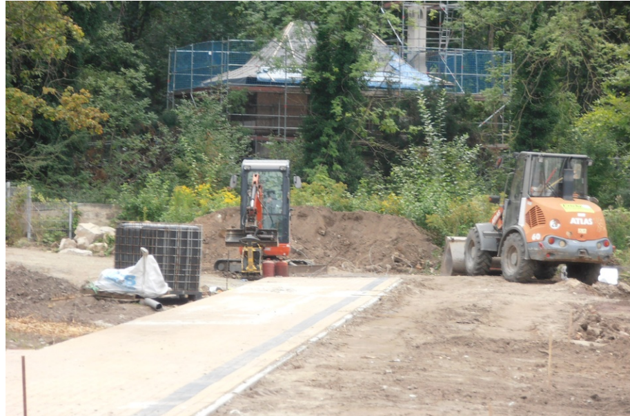
Der Pipenweg entsteht, im Hintergrund das Kontorhaus
