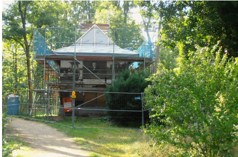
Baustelle des Kontorhauses, Spätsommer 2020
