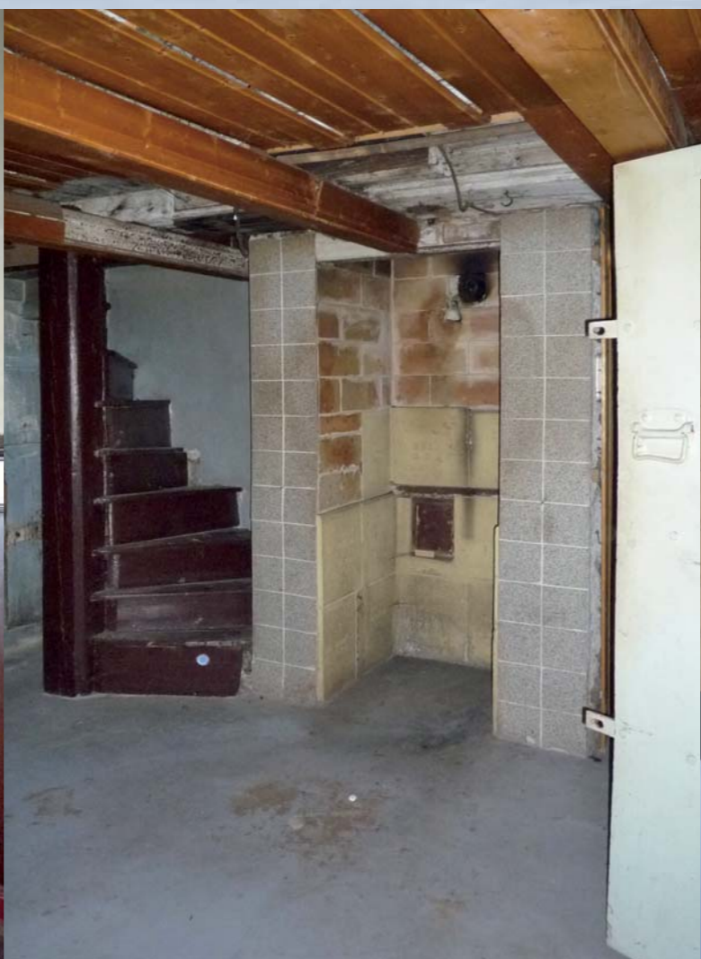
links oben: Nordseite EG mit großem Fenster. Auf dem Fußboden vor der Wand die Schlitz für die Heizung aus dem Untergeschoss. Elektroinstallation insgesamt auf Putz | rechts oben: UG mit Kaminanschluss in der Nische. Holzbalkendecke mit Eisenträgerverstärkung. Treppe aus dem EG und Verkleidungen nachträglich, Zementestrich als Fußboden | links unten: UG nach Südosten mit Tür zum Nebenraum | rechts unten: Spitzboden nach Westen
