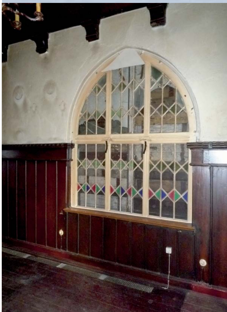
links oben: Nordseite EG mit großem Fenster. Auf dem Fußboden vor der Wand die Schlitz für die Heizung aus dem Untergeschoss. Elektroinstallation insgesamt auf Putz | rechts oben: UG mit Kaminanschluss in der Nische. Holzbalkendecke mit Eisenträgerverstärkung. Treppe aus dem EG und Verkleidungen nachträglich, Zementestrich als Fußboden | links unten: UG nach Südosten mit Tür zum Nebenraum | rechts unten: Spitzboden nach Westen
