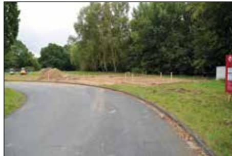
Am Wendehammer der Buslinie 418 soll das Empfangsgebäude stehen
