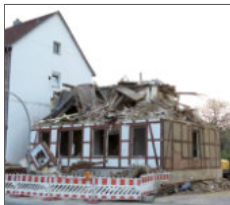
2010 wurde bereits das Fachwerkhaus Kreuzstraße 105 abgerissen.
