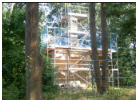
Baustelle Kontorhaus am 13.08.2020
