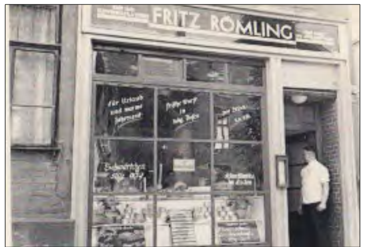
Bild 4 Römling mit Fenster
