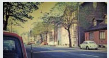
Bild 3 Luisenstr Nordseite Blick nach Westen
