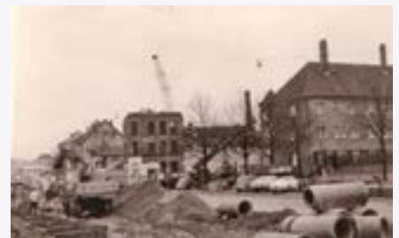
Bild 6 Abriss Kreuzung Juliusstr. / Luisenstr. Köhler
