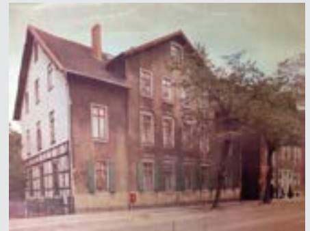
Bild 2 Haus Nr. 27 Luisenstraße vor Abriss
