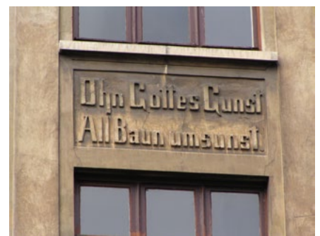
Aufnahme aus den 1960er Jahren Fassadendetail
