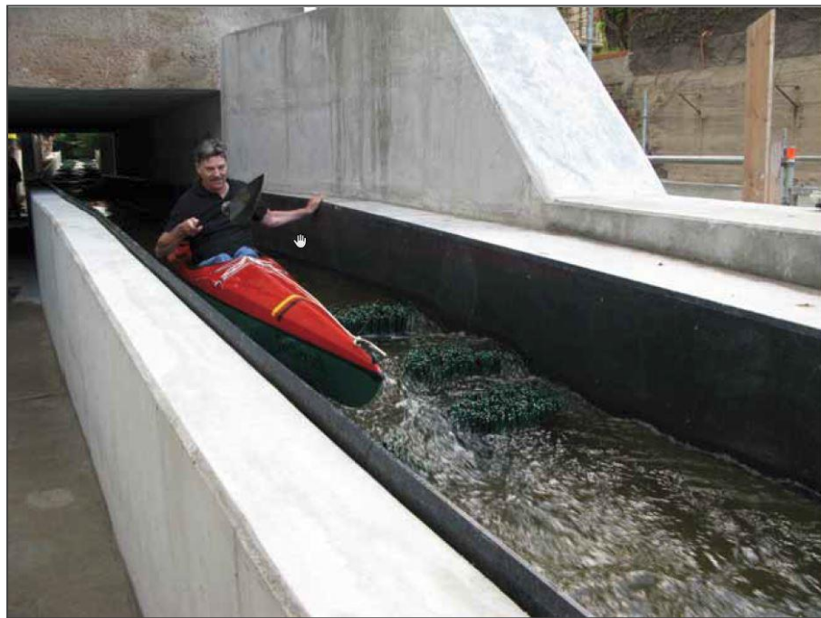
Abb. 3.1: Beispiel für einen Fischkanupass (Quelle: Dr. Hassinger)
