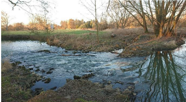
Abbildung 1-1: Wehr Bienrode mit sich anschließendem Kolk
