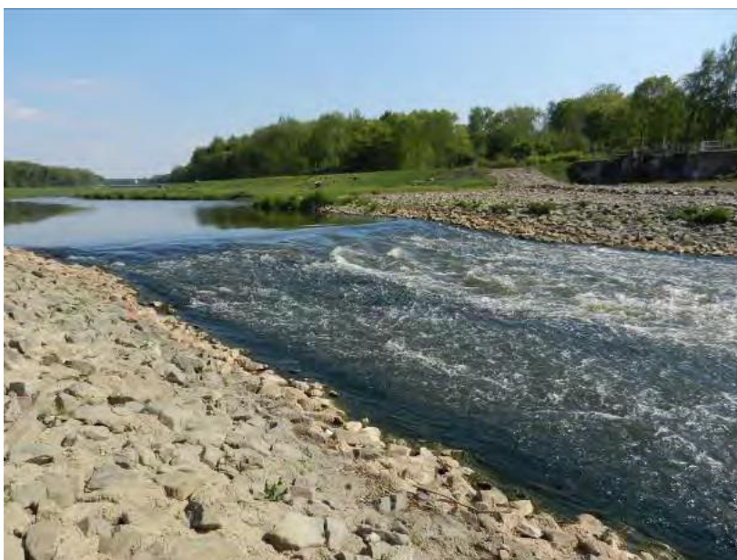
Abbildung 3-2: Raugerinne ohne Einbauten (Quelle: DWA-M 509)
