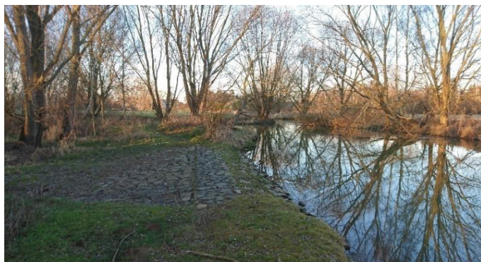
Abbildung 2-3: Hochwasserentlastungsschwelle oberhalb der Abzweigung
